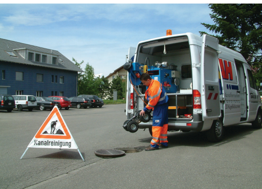
Inspektion von Abwasserleitungen mit dem PANORAMO.
