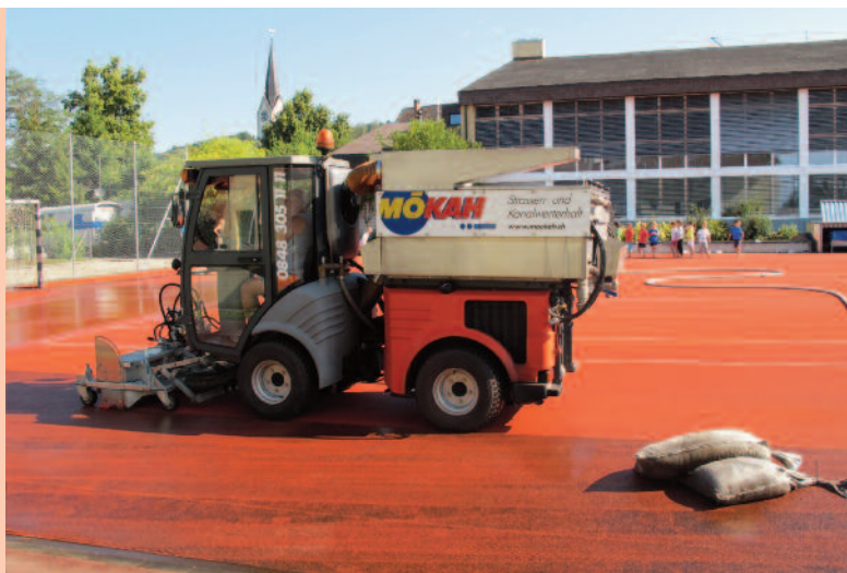
Der Turbocleaner im Einsatz – rechts die Feststoffe in 30 kg Säcken verpackt für die Sondermüllentsorgung
